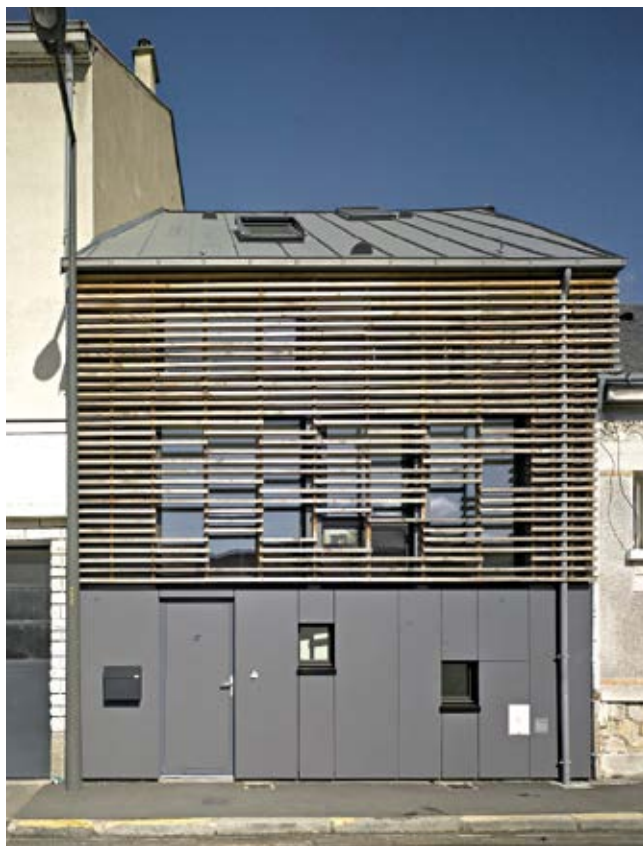
Construction d'une maison à ossature bois en centre-ville (en secteur sauvegardé et en zone inondable)
